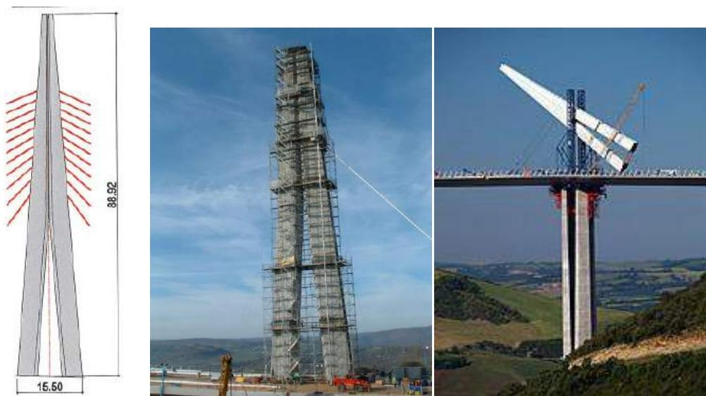
Figure IX.9 : Les pylônes en V inversé du Viaduc de Millau
