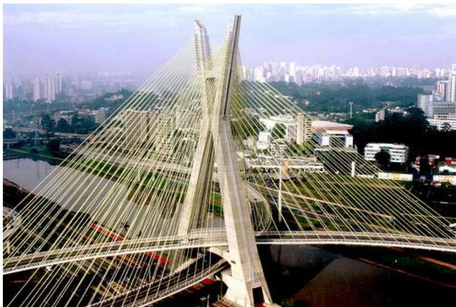
Figure VIII.3 : Le pont Octávio Frias de Oliveira, Sao Paulo, Brésil est un pont haubané inclassable du point de vue de sa structure de nappes.
