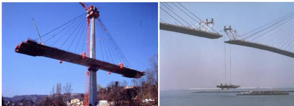
Figure IX.12 : hissage d'un voussoir lors de la construction en encorbellement d'un pont.
