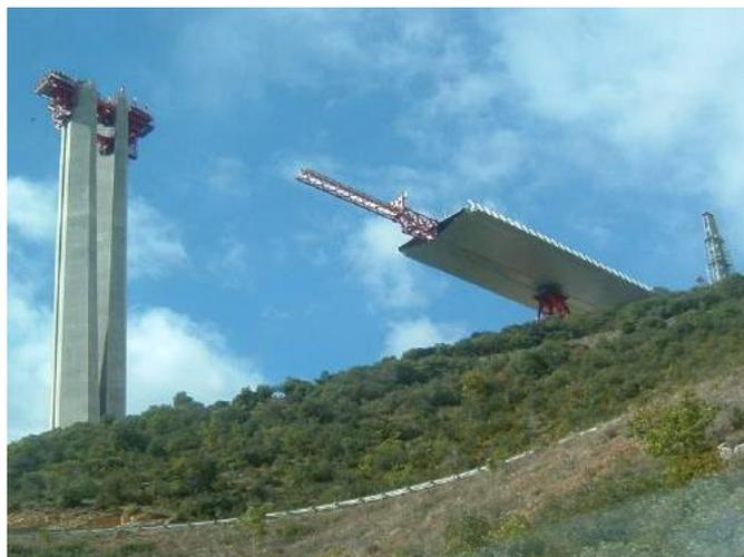
Cependant, dans certains cas, la distance entre les piles étant trop importante (comme pour le viaduc de Millau), il faut préalablement installer des pylônes provisoires (appelés palées) entre les piles existantes, comme un échafaudage qu'on n'a plus qu'à enlever à la fin des travaux. Une fois le tablier en place, on le fixe aux piles et on met les haubans sous tension. Il ne reste plus qu'à enlever les éventuelles palées provisoires, le pont est terminé.
