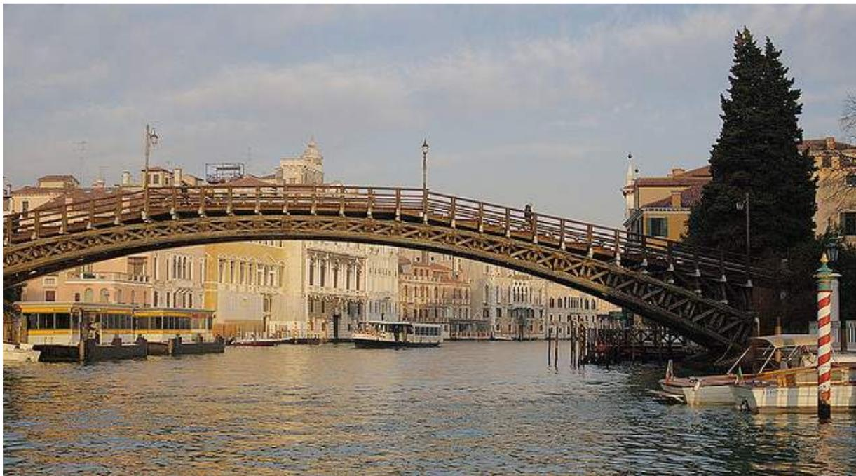
Figure V.1: Ponte de l'Accademia, Venise, Italie : en bois goudronné et destiné à n'être que temporaire, il fut construit en 1934 et reconstruit à l'identique dans les années quatre vingt.
