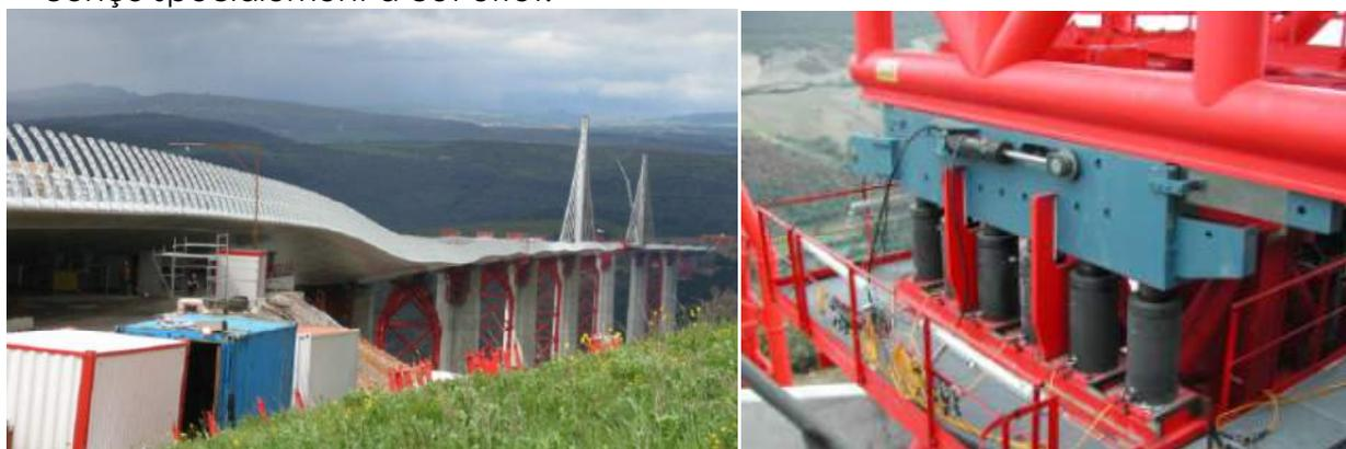
**Figure IX.14 : Lançage du tablier du Viaduc de Millau : cette phase de la construction a exigé une longue réflexion et la mise en place de procédés et structures impressionnantes. A gauche, le translateur sur une pile provisoire.**
