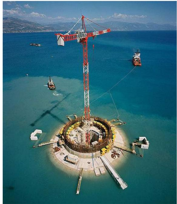
Fig. IX.2 : Construction et fondation du pont de Rion-Antirion - Grèce
