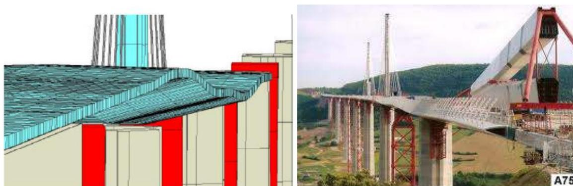
Figure A4 : Le bureau Greisch est intervenu à différents moments de la construction du Viaduc. Un véritable défi consistait au lancement et positionnement du tablier à 200 mètres d'altitude. Ici à gauche, les déformations calculées et à droite, les déformations réelles.
