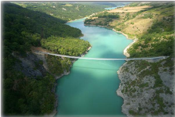
Un des ponts des plus simples et des plus connus des randonneurs est sans doute le pont Himalayen. Il s'agit d'un ouvrage souple, suspendu par ses deux extrémités et qui pend librement à la façon d'une chaîne ou d'un collier. Mais derrière son apparente simplicité, ce pont cache une courbe bien connue des mathématiciens : la bien dénommée *chaînette*.
