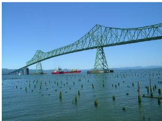
FigureV.4 : Astoria-Megler Bridge, Oregon, USA : Pont à poutres cantilever en treillis
