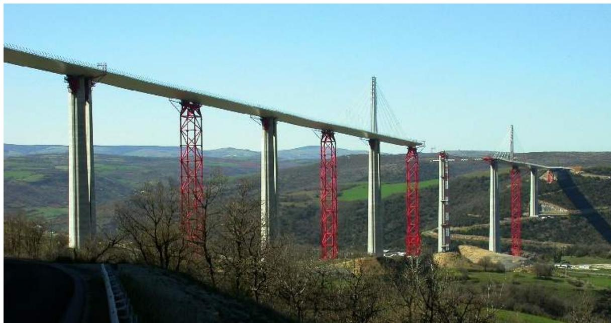
Figure IX.16 : Viaduc de Millau avec appuis provisoires en structure métallique rouge.
