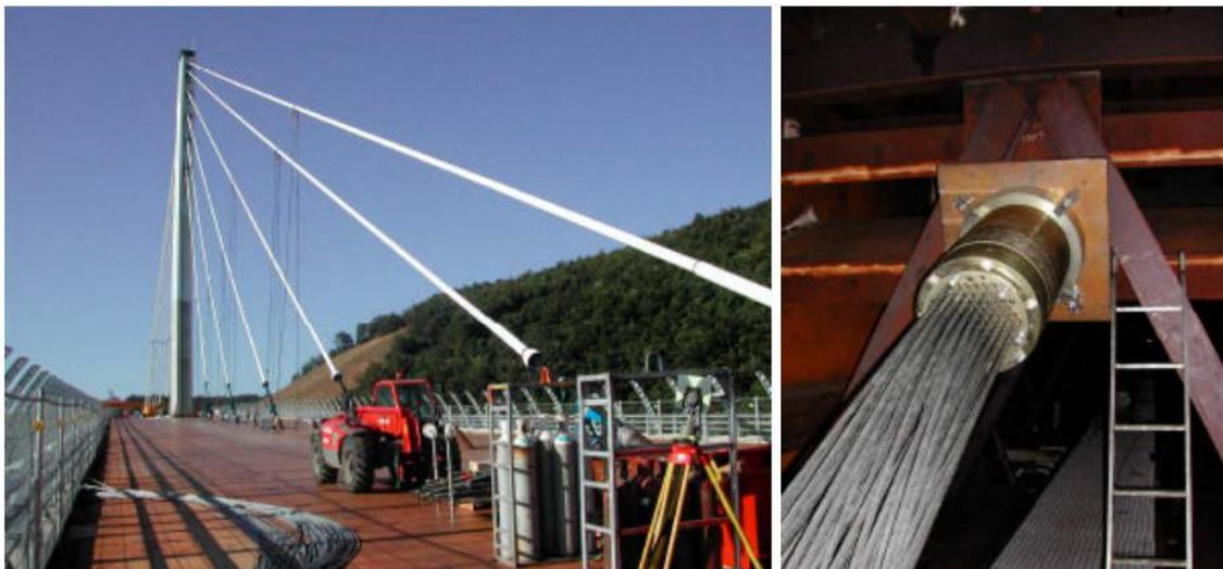
Figure IX.19 : Haubans du Viaduc de Millau et sa tête d'ancrage.
